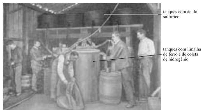
Equipamento de Santos-Dumont para produção de hidrogênio
