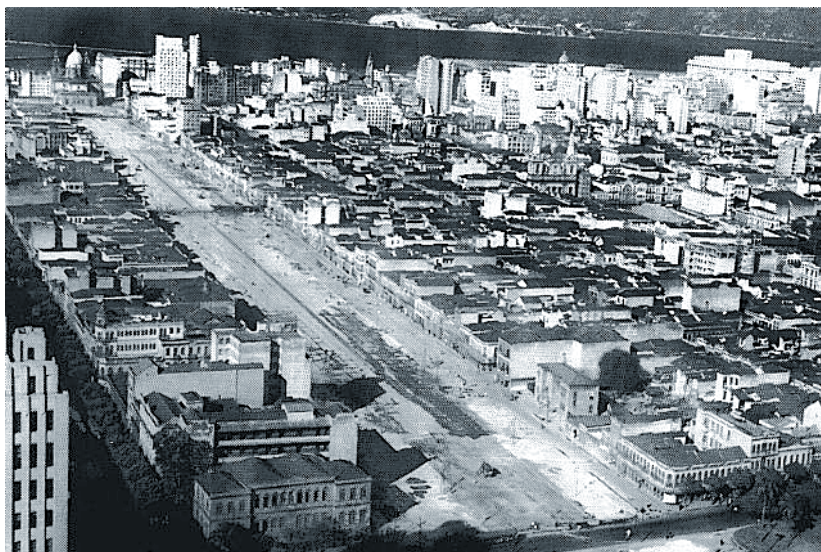
Construção da avenida Presidente Vargas
